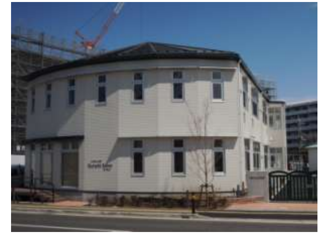
公園正門側外観
