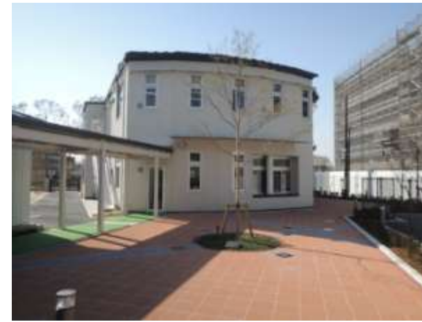
東側広場からの外観 (受付、玄関)
